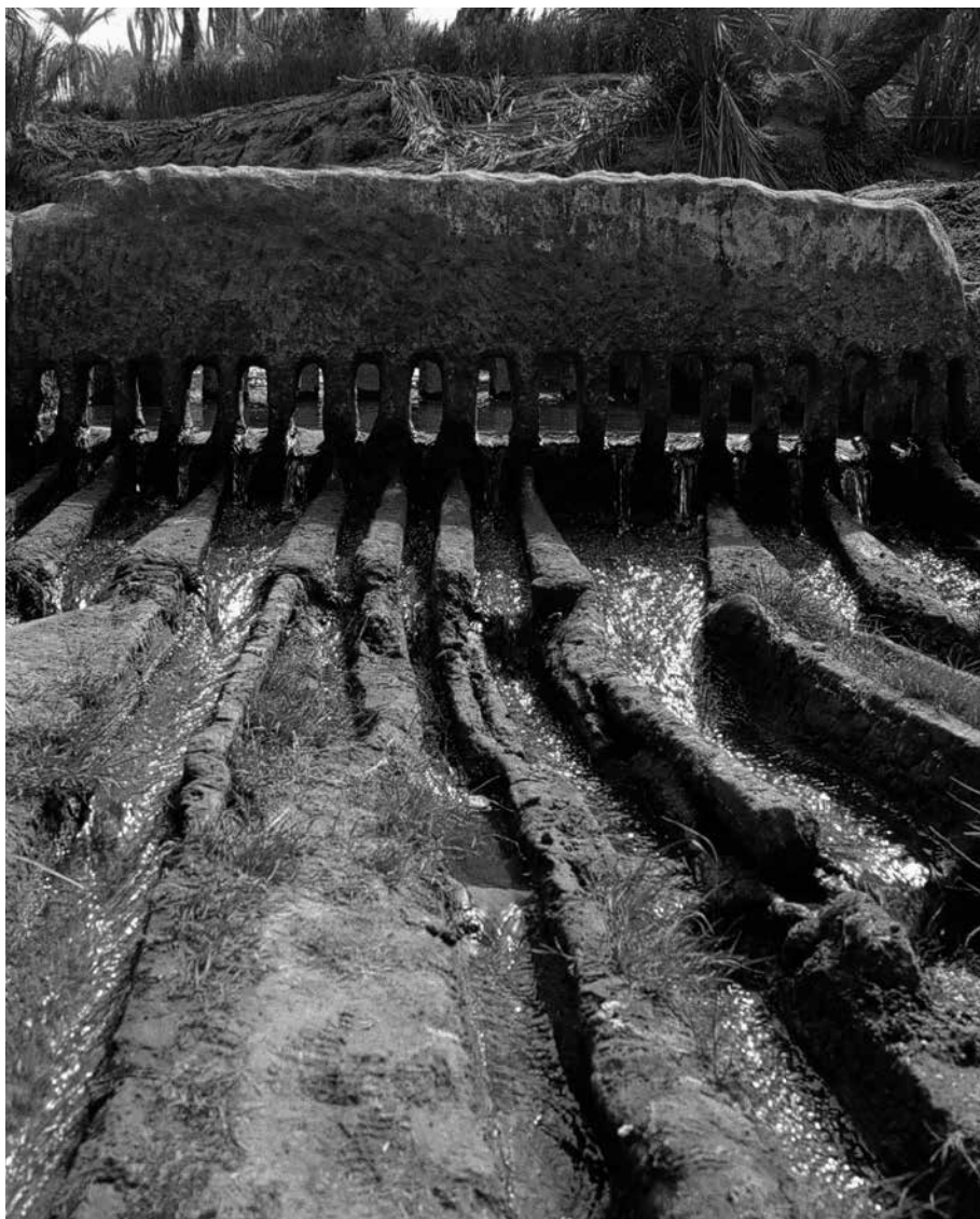
Foto 13 Pietra di ripartizione per la gestione delle quote d'acqua. Timimoun, Algeria
