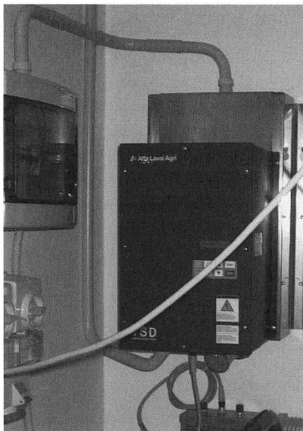
Fig. 1 Il variatore di regime di rotazione della pompa per vuoto (inverter) consente di ridurre del 50-70% i consumi di energia elettrica
