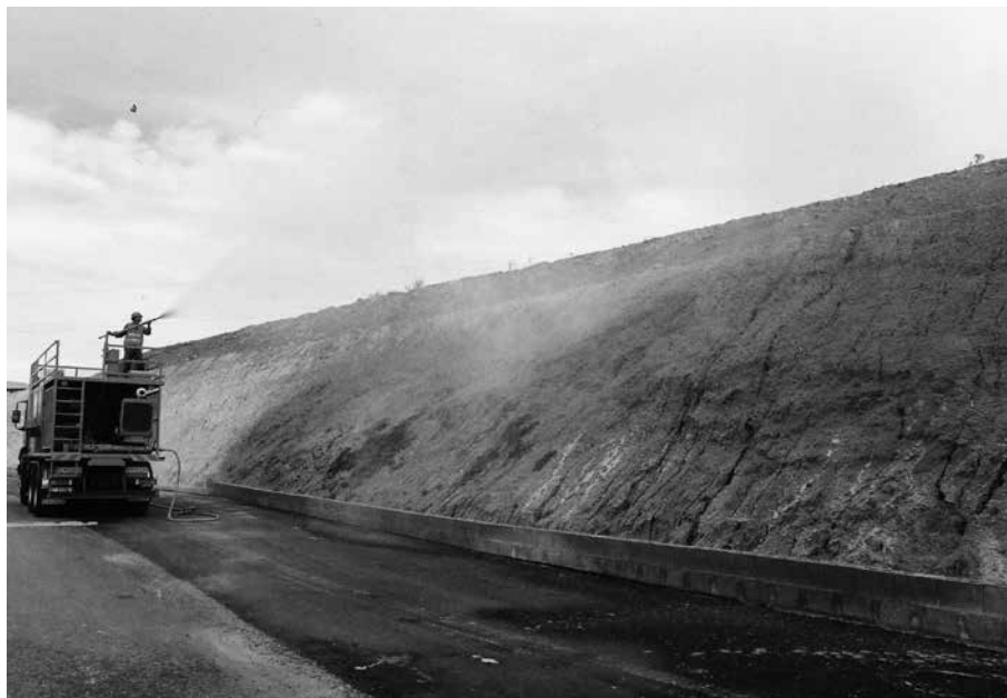
Fig. 8 Idrostolonizzazione
