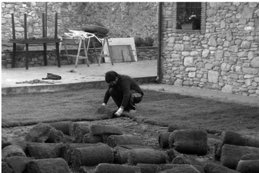
Fig. 4 Impiego di tappeto erboso in rotoli
