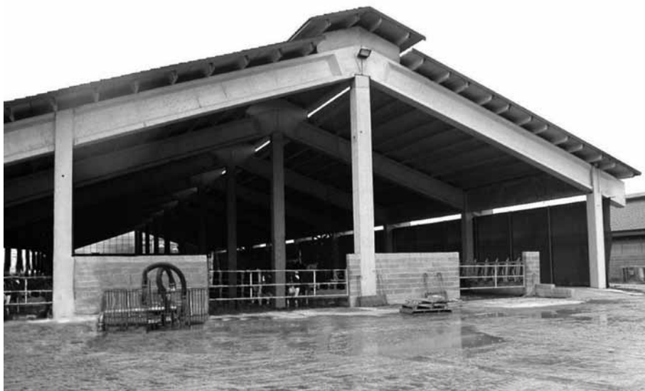
Fig. 12 Struttura con elevata pendenza delle falde e apertura al colmo coperta da cupolino
