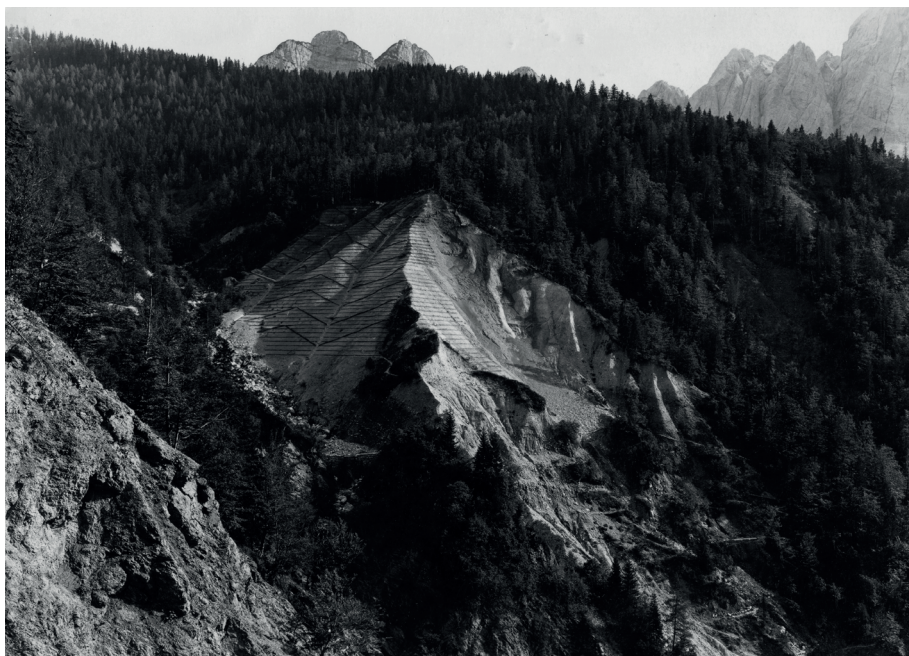
Fig. 4 Lavori di sistemazione idraulico-forestale di una pendice calanchiva soggetta a erosione eseguiti dal Corpo forestale dello Stato negli anni '60
