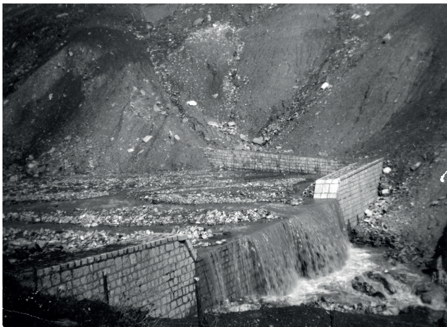
Fig. 3 Realizzazione di briglia di contenimento per consolidare le sponde di un torrente e impedirne fenomeni erosivi (Foto archivio CFS)
