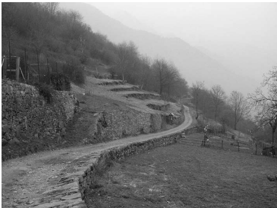
Fig. 1 Terrazzamento come sistema di paesaggio: strada di accesso, muro di sostegno, rampa di collegamento, canali di scolo, terrazzi coltivati ecc... le esigenze locali fanno mutare nel tempo sia gli usi sia l'aspetto formale
