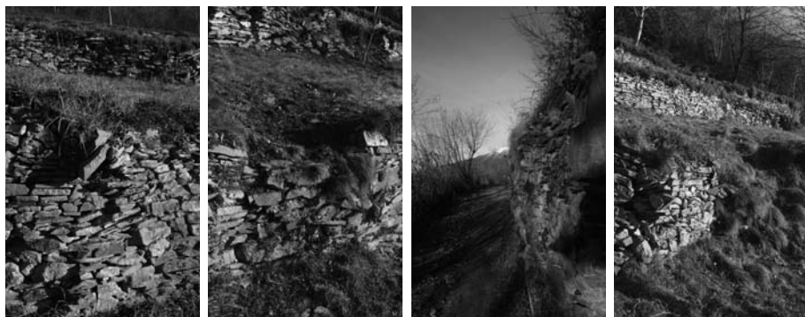
Fig. 2 I livelli di degrado della muratura a secco (da sinistra a destra): degrado localizzato del coronamento (A), degrado diffuso della parte superiore di muro (B), spanciamiento del muro (C), crollo di porzione di muro (D)
