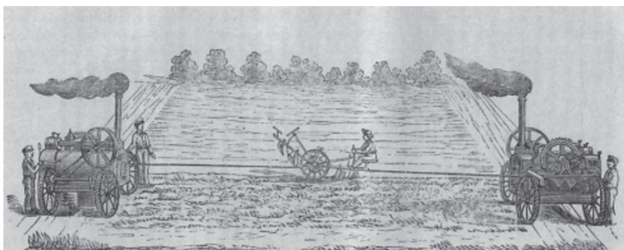
Fig. 6 Aratura funicolare con macchina a vapore sistema Ferretti-Fioruzzi
