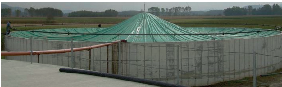
Fig. 8 Copertura in materiale plastico posta sopra la vasca di stoccaggio del liquame digerito per abbattere le emissioni di metano e ammoniacale
